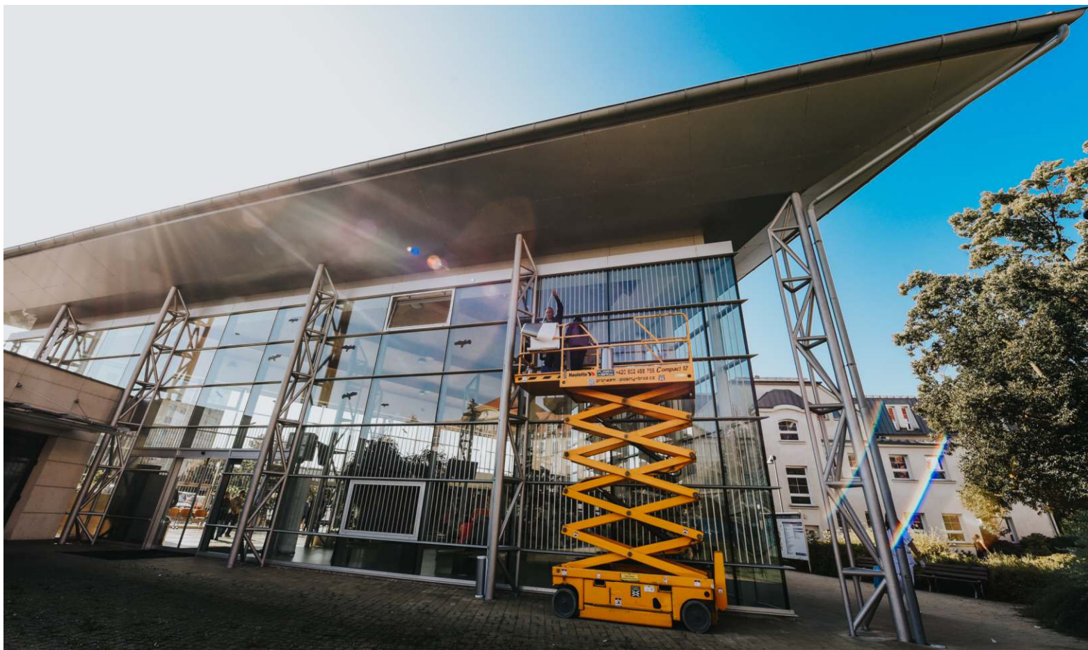
Průběh instalace reflexních pruhů na skleněné tabule vstupního terminálu / foto: Ing. Jana Duco, MBA
